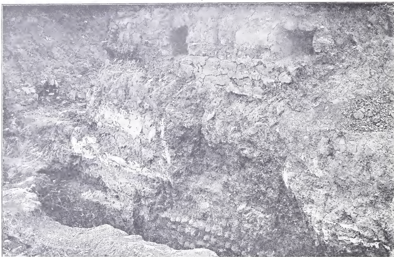
Abb. 157. Teil der Nordwestwand von J 3, schräg von Norden her gesehen; man beachte oben die Löcher für Holzbalken, die Reste des sehr dicken Wandberufs und das hier ausnahmsweise aus ganz kleinen Steinen bestehende Fundament. v. Luschan phot. 1902.
